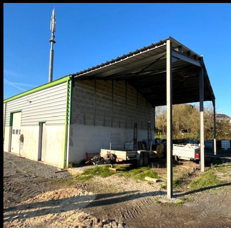
Création d'un auvent aux ateliers
