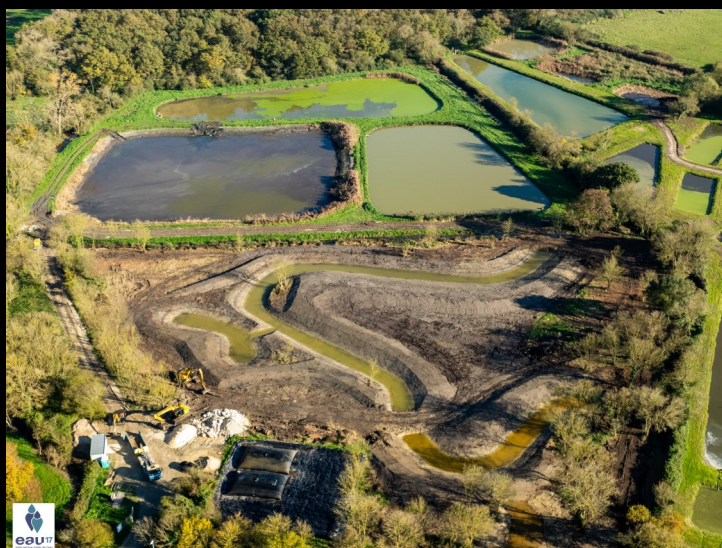
Extension de la station d'épuration
