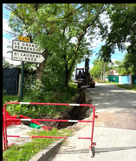
Effacement des réseaux aériens
