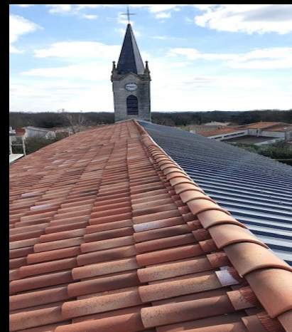
Bacs acier avant l'installation des panneaux photovoltaïques
